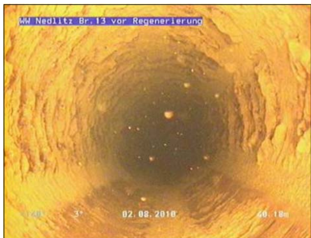
Фотографии из скважин с проволочными и пластмассовыми фильтрами до и после обработки методом hydropuls ®
