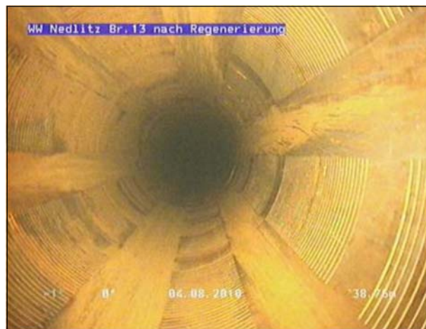
Фотографии из скважин с проволочными и пластмассовыми фильтрами до и после обработки методом hydropuls ®
